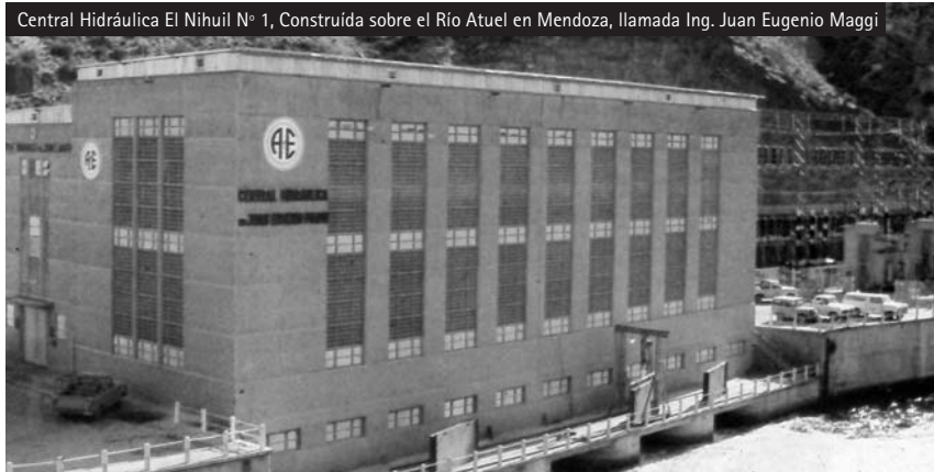
Central Hidráulica El Nihuil N° 1, Construida sobre el Río Atuel en Mendoza, llamada Ing. Juan Eugenio Maggi
